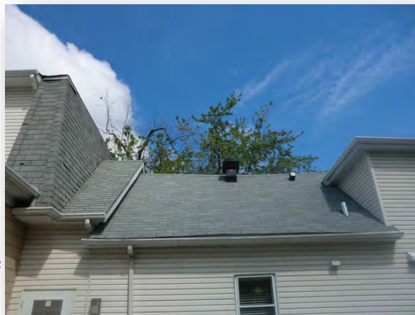
Réfection de la toiture
