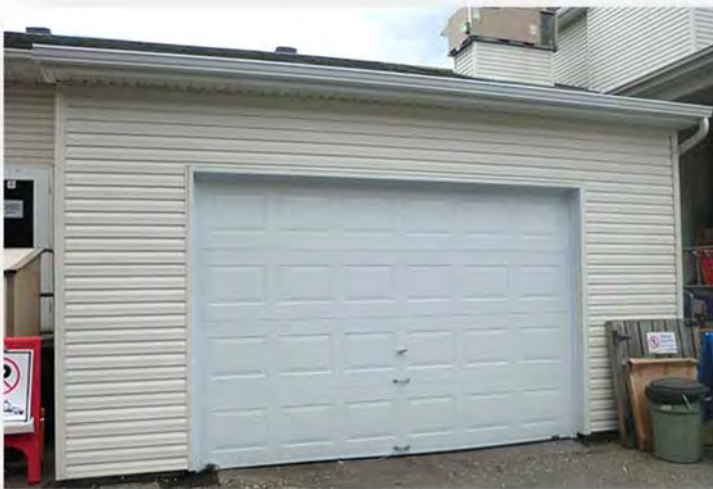
Rangement extérieur afin de garder les objets à l'abri des intempéries
